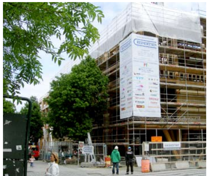
Byggeplassbannere for Reinertsen. Totalt 6 stk levert med en størrelse på 4 x 12 meter.
